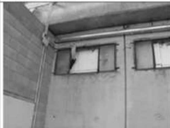
18. parete di est. Isolante dietro il cartongesso. Presenza di impianti passanti.
