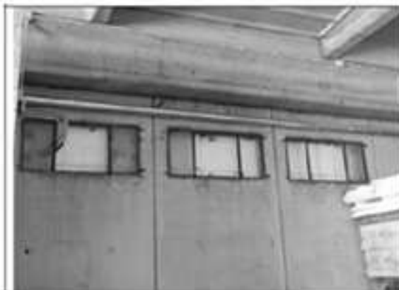
16. parete di est. Isolante dietro il cartongesso. L'aria passa dagli impianti dietro il cartongesso ed entra in contatto con l'aria di questo capannone. Chiudere e sigillare le aperture di finestra ed anche i fori presenti nel c.a.
